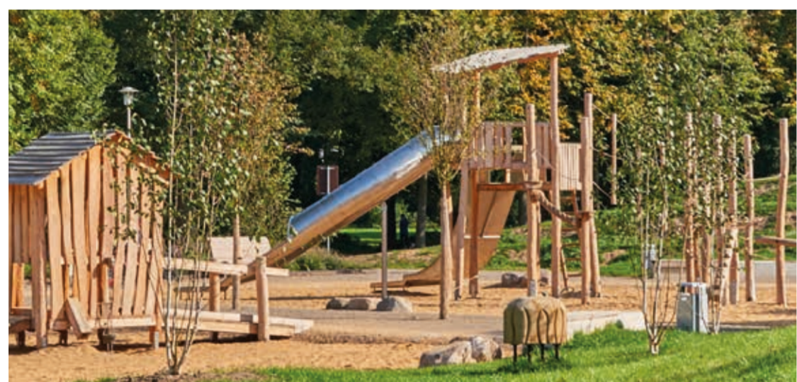
Holzbendenpark Bauabschnitt 1: Neugestaltung des Spielplatzes
