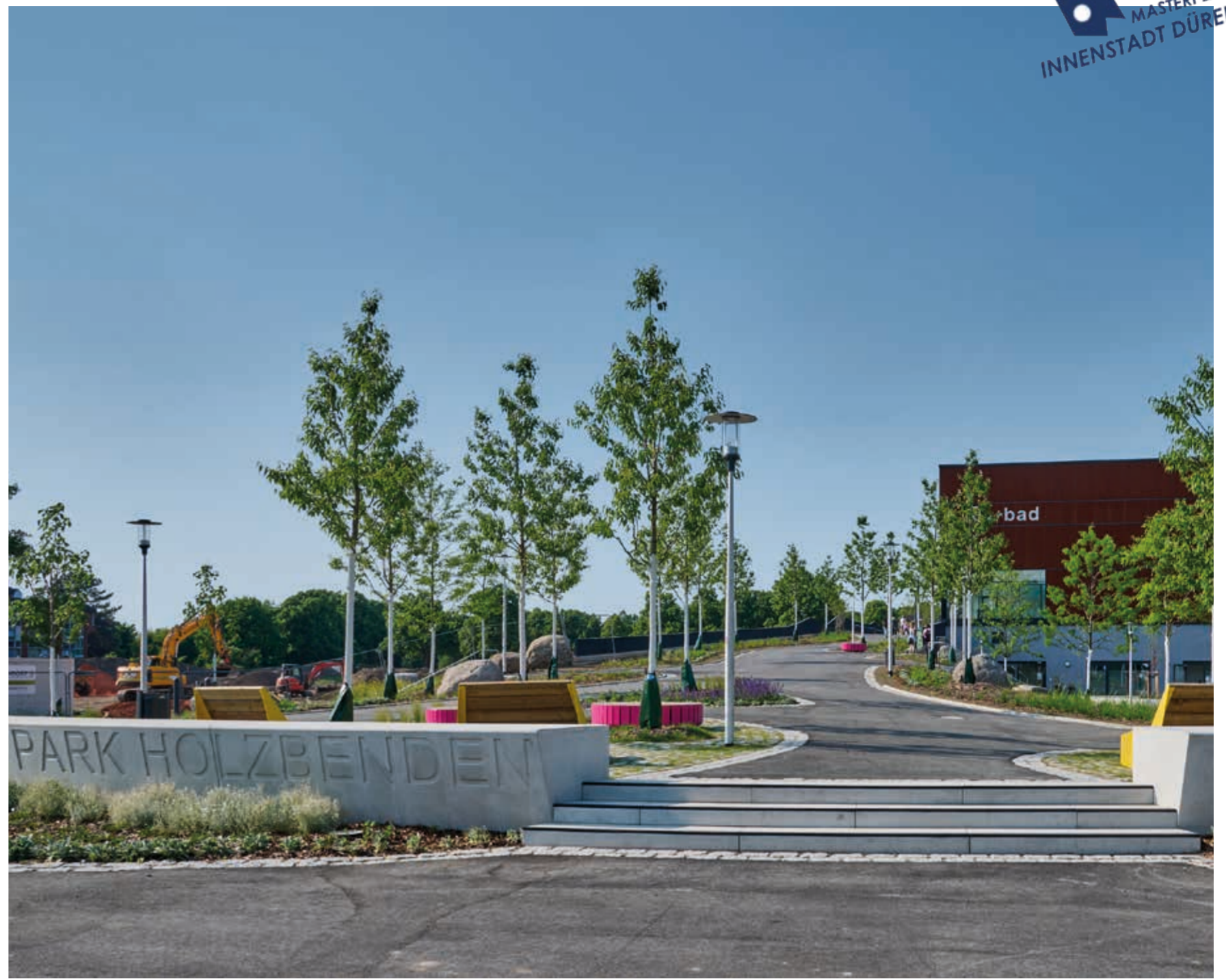
Holzbendenpark Bauabschnitt 2: Der neu geschaffene Südzugang lädt ein und macht neugierig
